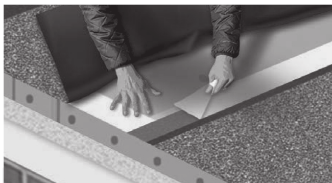
Solapamientos laterales de remate
