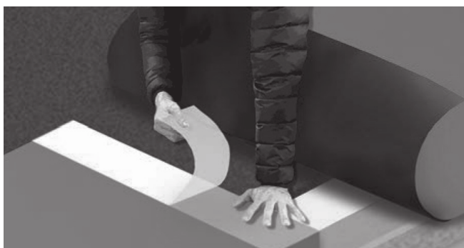
Solapamientos finales de láminas de base/capas intermedias
