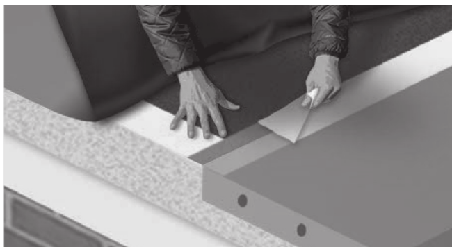
Raccords latéraux de couche de base/intermédiaire
